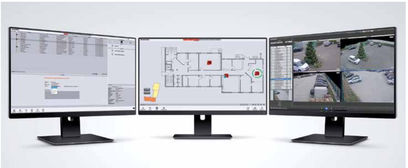
▲ Universelles Sicherheitsmanagement integriert alle Sicherheitseinrichtungen und bietet eine einheitliche Administrationsplattform, um im Störungs- oder Alarmfall eine schnelle und reibungslose Intervention zu gewährleisten. Foto: Securiton Deutschland
